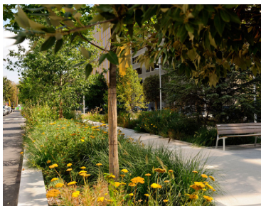
Rengbädd nedsänkt för att leda in dagvatten
