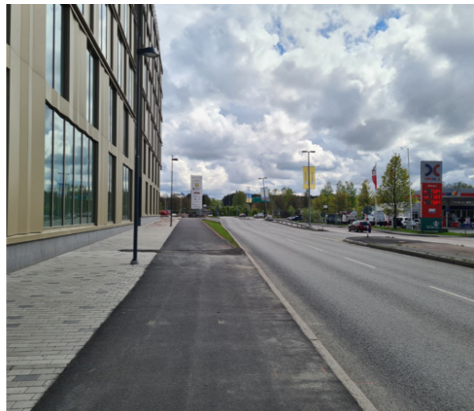
Jordbrovägen idag, fasad Jordsbruksverket och färdigställd gång- och cykelbana.
