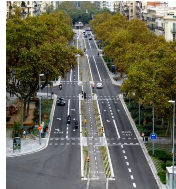
Passeig de St Joan boulevard, Barcelona. Centrerad trafiklösning och stora gångzoner med planteringar utmed fasad. Av Lola Domènech.
