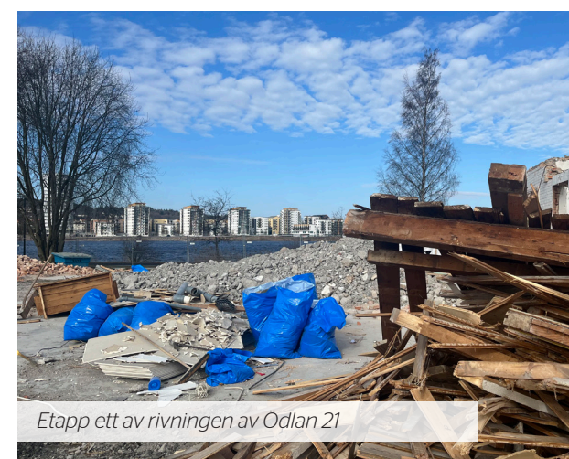
Etapp ett av rivningen av Ödlan 21
