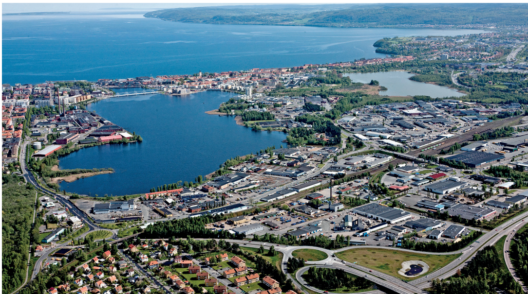
Bild tagen från sydväst över omvandlingsområdet som det ser ut i dagsläget. Bild från Ramprogram för Södra Munksjön.
